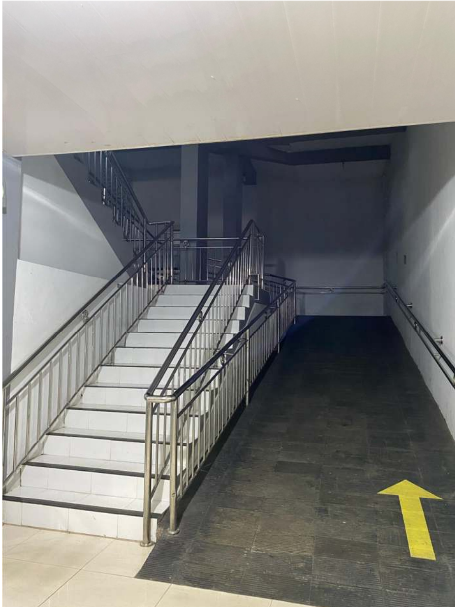
Jalan landai dengan pegangan rambat
